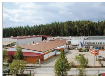
Blick auf das BGU-Stammhaus in Ansbach.
